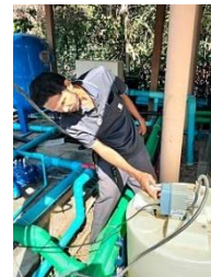
รูปภาพ : ตรวจสอบรอยรั่วของท่อจ่ายน้ำ บริเวณรอยต่อและปั๊มสูบน้ำ เพื่อลดการสูญเสียการใช้น้ำ
